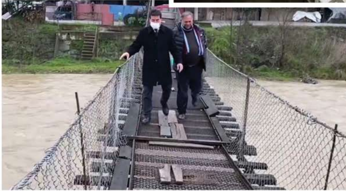
Karakaş Mevcut Asma Köprüsü
